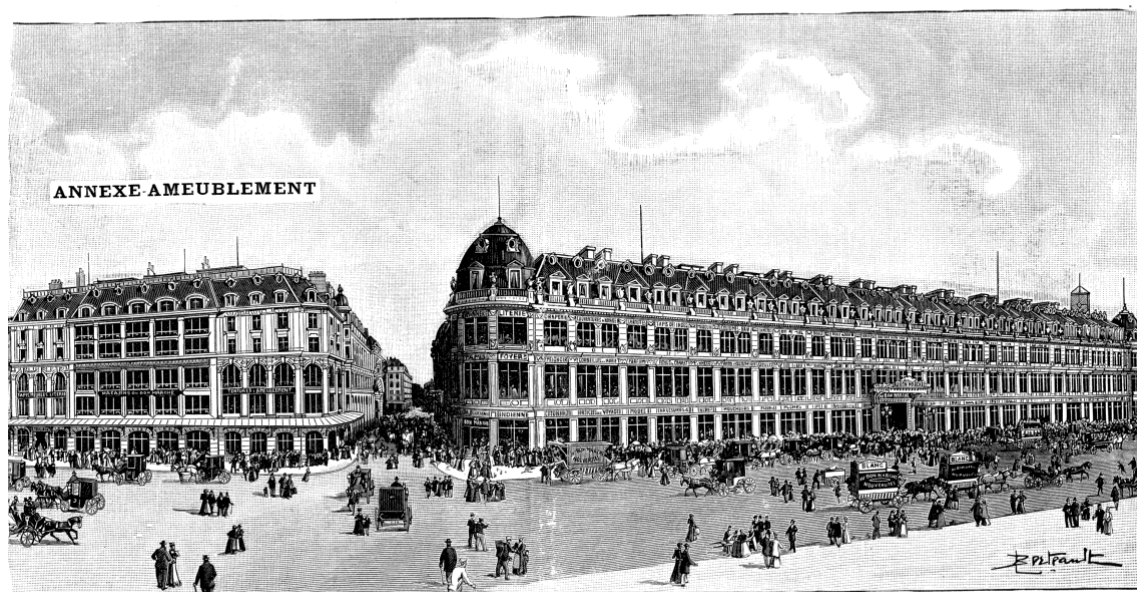
VUE des MAGASINS, RUE du BAC
